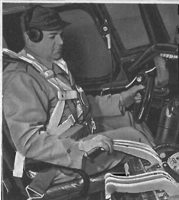
Il pilota Fisher manovra le leve che comandano la inversione del passo delle eliche nel suo Douglas DC-4.
